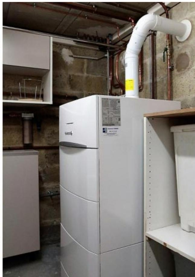
*Remplacement d'une chaudière gaz ancienne génération par une chaudière gaz condensation De Dietrich Modulens AGC25/100HL.*
